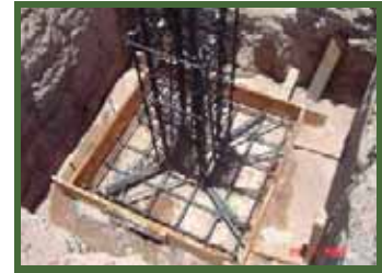
Imagen 23: Zapata Aislada. 24
