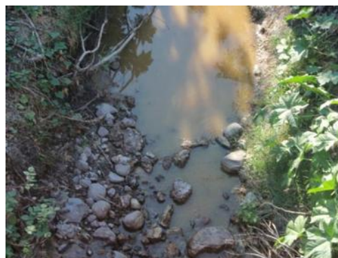
IMAGEN 39.-DESAHUE DEL DRENAJE
