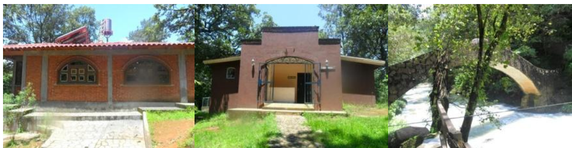
IMAGEN 59, Cabañas Descripción: Unas de las 3 cabañas con instalaciones naturales como calentadores, con 2 recamaras. Fotógrafo.- Patricia A. Gracián Fecha: Agosto/27/2011.
