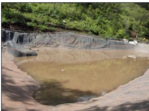
IMAGEN 69.- BORDO DE CAPTACION PLUVIAL
