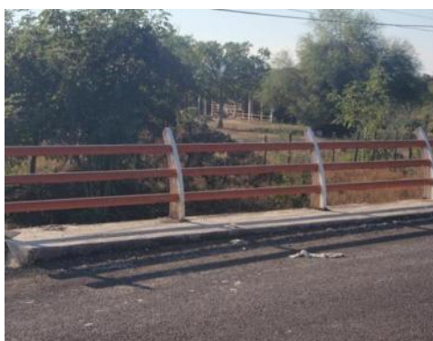
IMAGEN 38.-DESAHUE DEL DRENAJE
