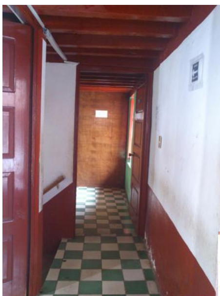
Figura 24. Pasillo de las Oficinas de Obras, Sindicatura, ecología. En las cuales el acceso es este pasillo José Raúl Velázquez Nambo
