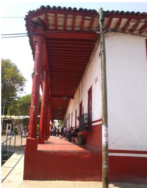
Figura 12 Portal Fachada Norte. Desnivel del edificio y en donde también se puede apreciar las lámparas que se utilizan y la vigería del portal, y la serie de columnas. José Raúl Velázquez Nambo.
