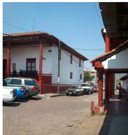
Figura 10 fachada Norte de la presidencia Mpal. Contexto urbano en donde se aprecia la calle adoquinada y el color rojo y blanco que prevalece en su entorno así también se aprecia su estacionamiento. José Raúl Velázquez Nambo
