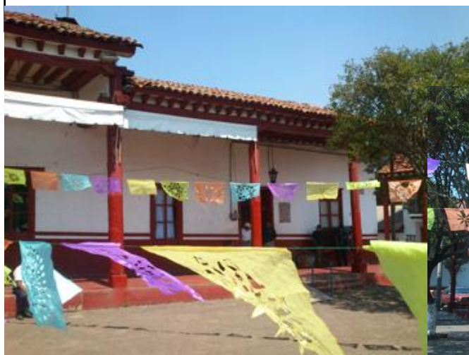
Figura 20 Fachada Principal del H. Ayuntamiento. Desnivel de techumbre, la viguería que la soporta y sus columnas que corren por todo el portal. José Raúl Velázquez Nambo
