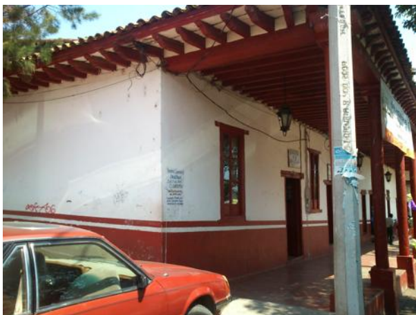
Figura 13 Portal Fachada Sur. Vanos de ventanas y puertas de las oficinas a lo largo del portal y el estacionamiento en su fachada sur. José Raúl Velázquez Nambo.
