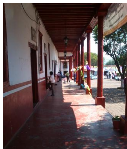
Figura 12 Portal Fachada Sur. En donde podemos apreciar la serie de columnas a lo largo del portal, también se aprecia que en la parte de enfrente esta la plaza del pueblo. José Raúl Velázquez Nambo.
