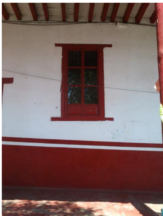
Figura 15 Ventana de la Fachada. En la cual se puede apreciar que son de madera a la vez esta contiene una serie de vidrios en forma de rectángulo. José Raúl Velázquez Nambo.
