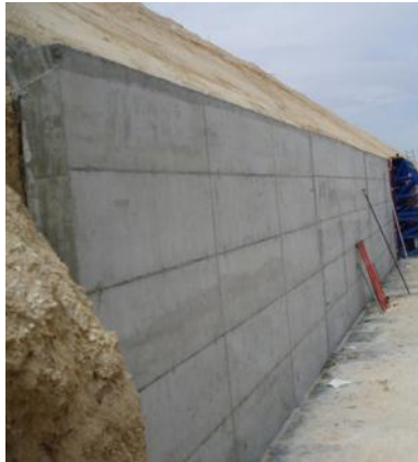
IMAGEN 41 Muro de Concreto Armado. http://www.sotelo-sotelo.com/urb_es.html consultado el día 12 de mayo del 2012
