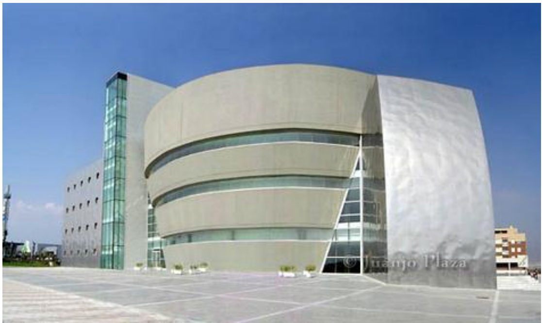
Fig. 68 Teatro-Auditorio de Roquetas de Mar, por Juanjo Plaza 30
