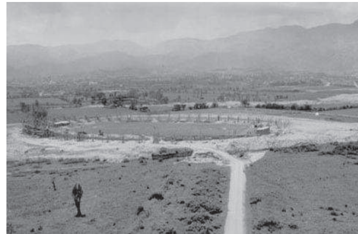
Fotografía 59.- Terreno en proceso de construcción
