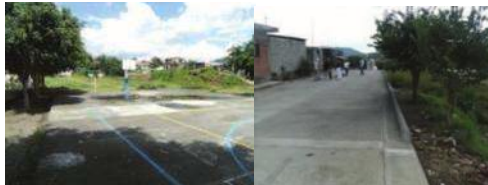
Fotografía 31.- Ejemplo de pavimentos de concreto
