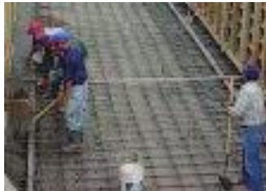
Fotografía 60.- Imagen de un ejemplo en la colocación del armado para el firme
