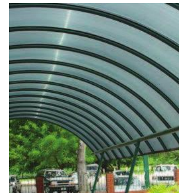
Fotografía 65.- Imagen de las placas de policarbonato que se utilizaran para la cubierta
