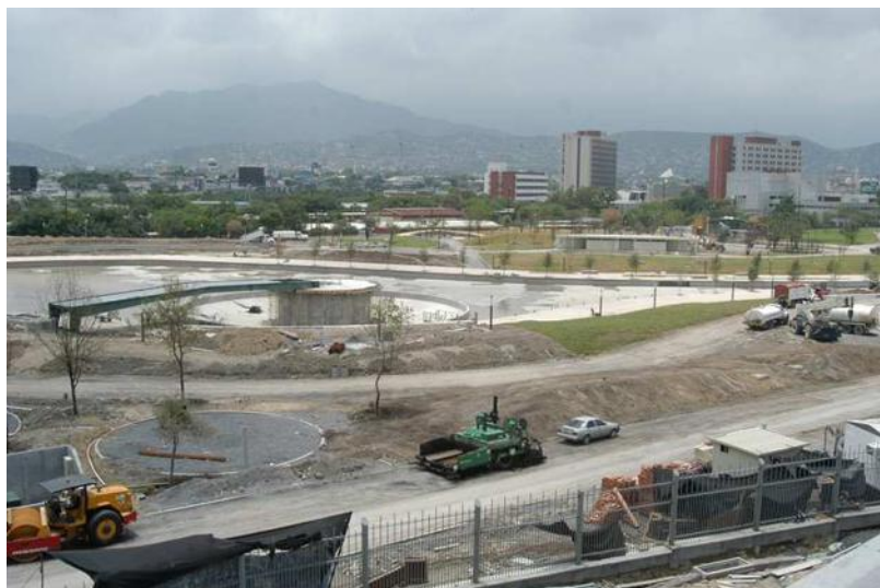
• Fotografía 11: Construcción del Paseo Santa Lucia.
