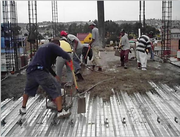
Fig. 48. Colado de losa acero.
