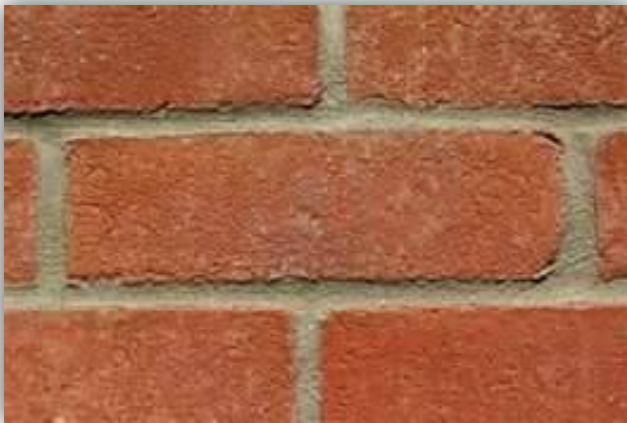
Fig. 40. Ladrillo en muro.
