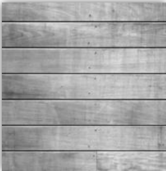
Fig.42. Acabado de concreto aparente.
