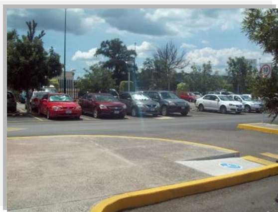
Fig. 4. Rampas en estacionamiento. Foto Karla Zavala Torres.
