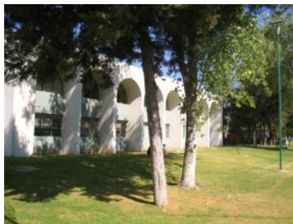
Fig.40.Der. EDIFICIO "P". Foto. RML.
