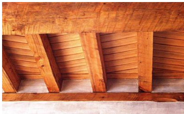
Fig. 7.8 Tejamanil en interiores.
