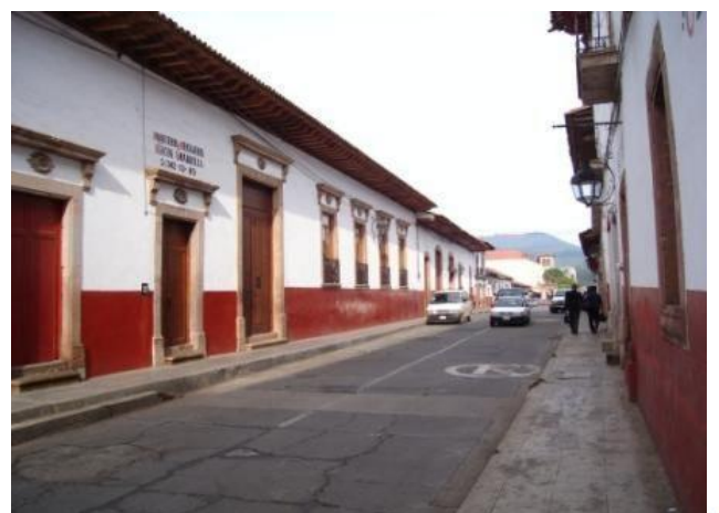
Fig. 9.7 Arquitectura de Pàtzcuaro.
