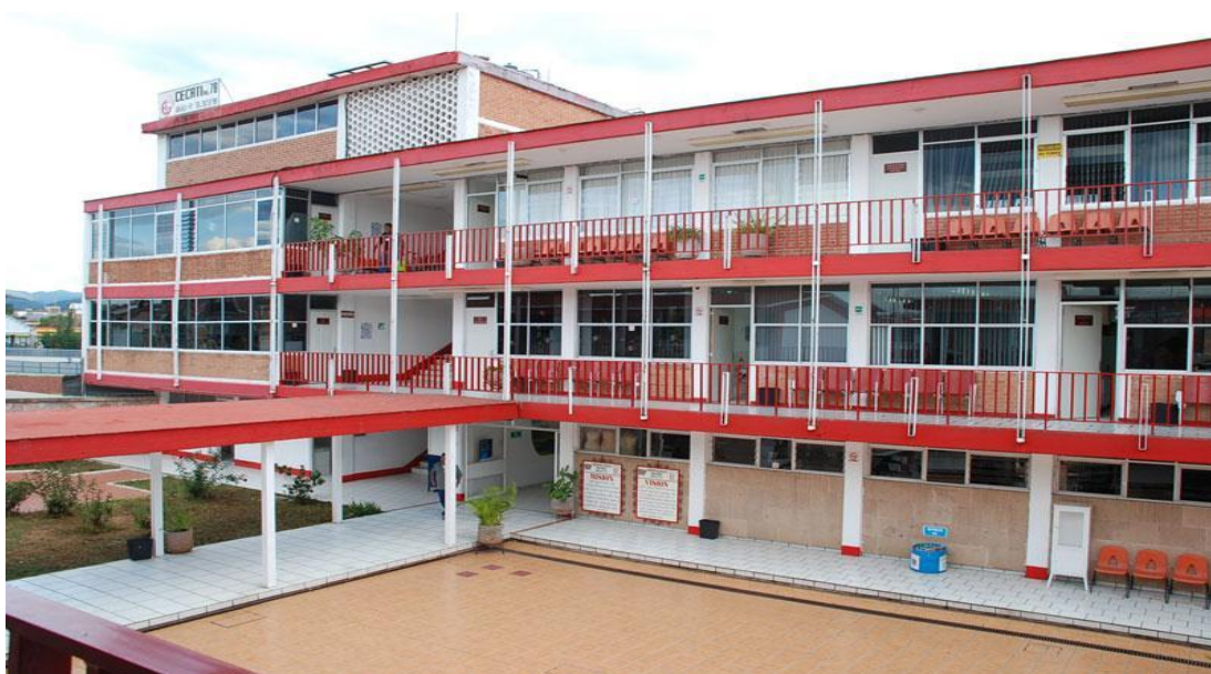
Fig. 2.2 Centro de Capacitación del Trabajo Industrial.
