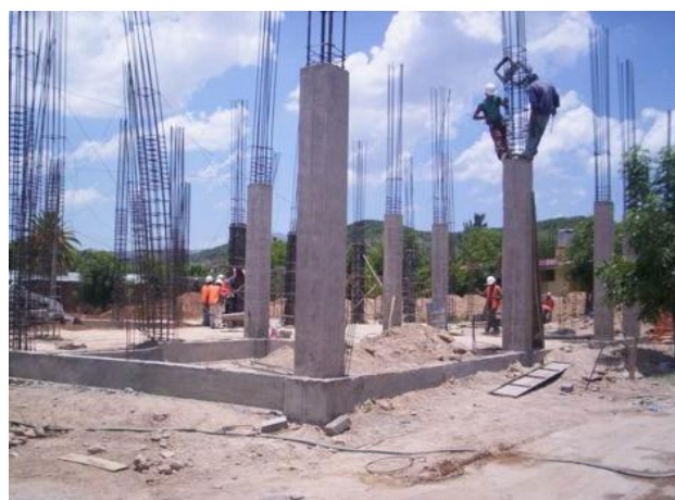
Fig. 7.5 Columnas de concreto.
