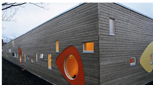
Imagen 1: Vista exterior de las guarderías. 3
