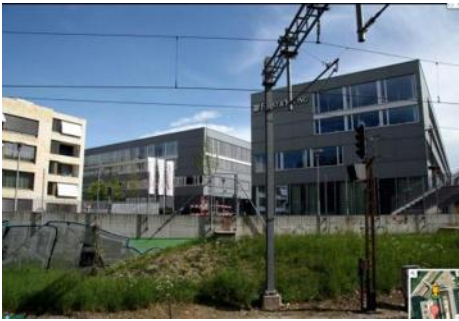
Imagen 69 Vista norte desde vías del metro, oficinas de Google, imagen de Google maps/panoramio.com
