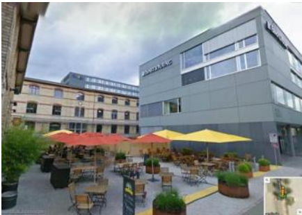
Imagen 71 Vista desde estacionamiento, oficinas de Google, imagen Google Maps.
