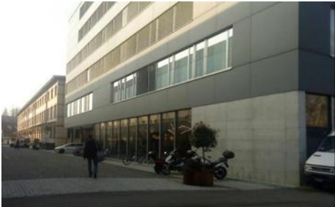
Imagen 70 Vista desde plaza de acceso/camino calle cerrada, oficinas de Google, imagen Google maps
