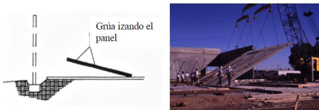
Imagen 49. Grúa izando paneles. Construcción Modular en Hormigón. p. 64
