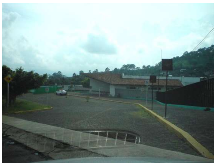
Acceso de la terminal de autobuses
