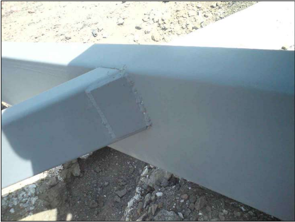
perfiles a utilizar en la estructura que sostendra la lamina multipanel uniones soldadas de los perfiles como se aprecia en la imangen de arriba
