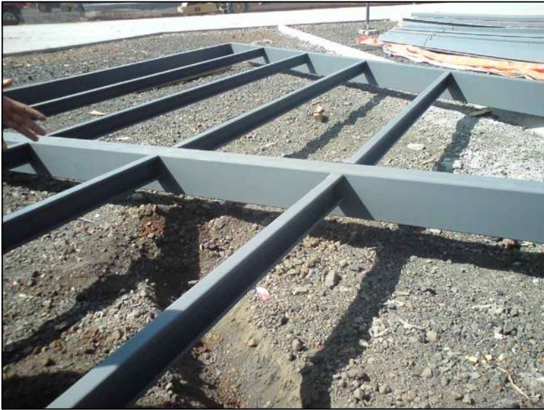
montenes soldados alas vigas, donde se atornillaran las laminas multipanel
