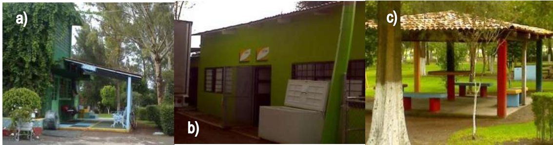
Ilustración 5: a) Oficina, b) Clínica Veterinaria, c) Kiosco
