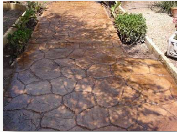
Ilustración 10. Tipo de pavimento aplicado en la construcción. Fuente: Cittys
