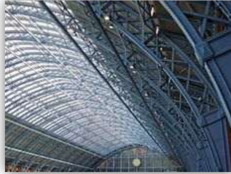
IMAGEN 5.1.1 Vigas reticuladas que permiten cubrir grandes claros.
