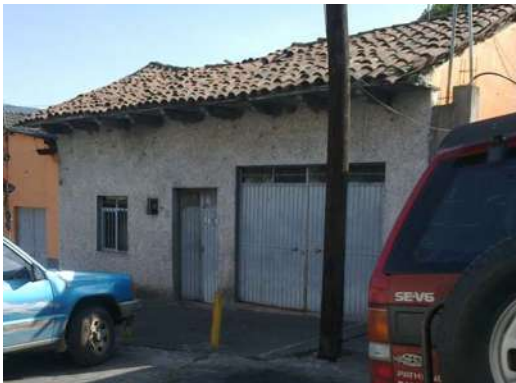
Imagen 17. Vivienda de adobe reforzada con castillos de concreto. Fuente: J.S.G.
