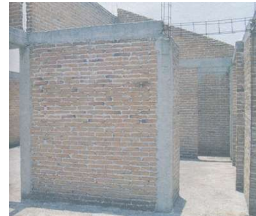
Imagen 27. Muro de tabique rojo, castillos y dalas.
