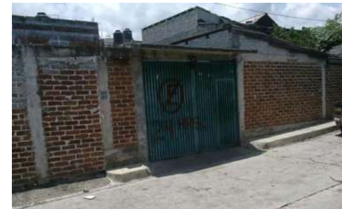
Imagen 25. Tipo de vivienda con tabique aparente. Fuente: J.S.G.
