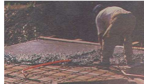
Imagen 26. Colado de losa maciza.
