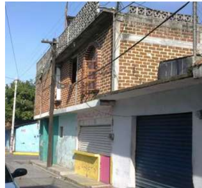
Imagen 24. Tipo de vivienda con tabique aparente. Fuente: J.S.G.
