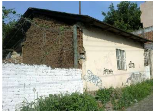
Imagen 18. Vivienda de adobe. Fuente: J.S.G.
