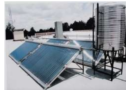
Imagen 30. Calentador solar modelo THA-H58/1800-24 y termotanque. Fuente: La web.
