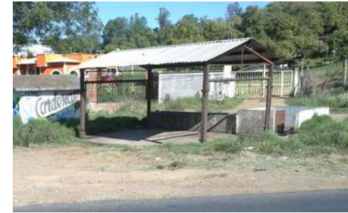
Imagen 1. Rastro insalubre que existen en el estado. Fuente: J.S.G.
