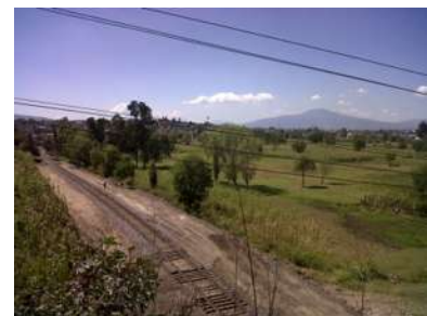
F100: No. 3 Condiciones del terreno. Fuente:[Tomada por Fco. Javier Cerda Náñez.]
