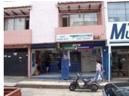
Oficina de telégrafos
