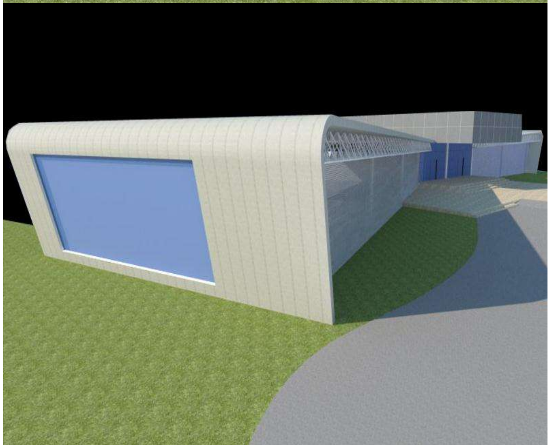
Maqueta Virtual 8-9. Análisis de confort térmico, vista en Elevación lateral, aprovechamiento de la ventilación natural por la parte superior donde se encuentra la estructura espacial abierta, generando una ventilación cruzada. Curvatura que baja hasta nivel de piso para cubrir de manera parcial los vientos dominantes.
