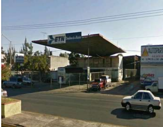
Fotografía 3. Instalaciones de ETN-Turistar 21/10/11
