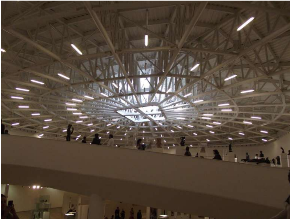
Foto 56: Rampa de circulación en un primer plano y al fondo se observa la estructura de la cubierta 80
