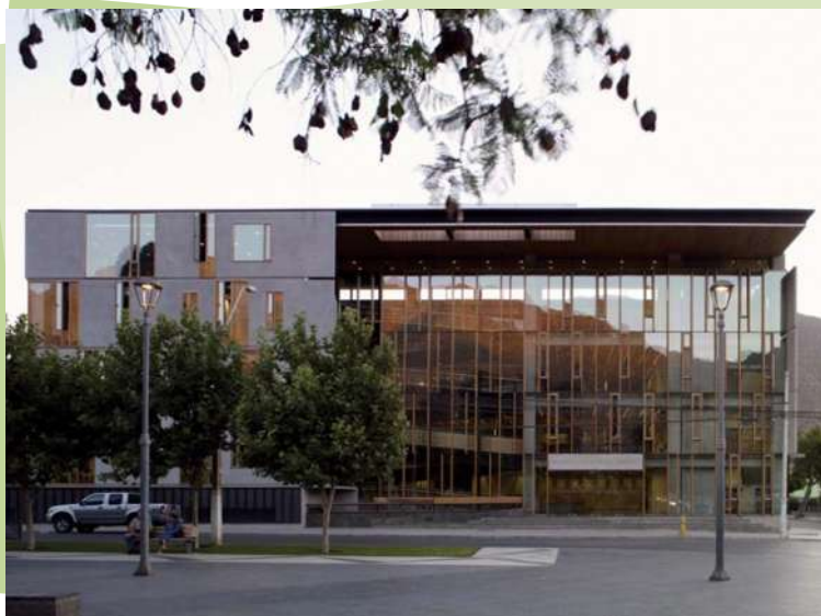
Fig. 61 Fachada principal. Se observa la utilización de las placas prefabricadas de concreto.
