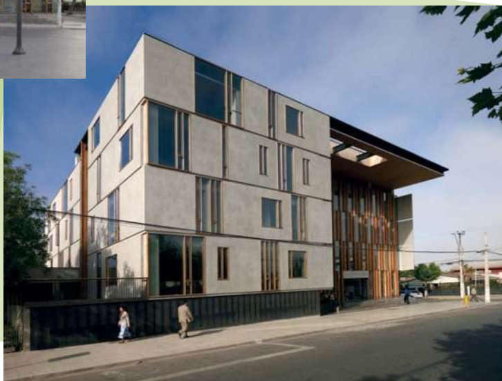
Fig. 62 Vista de la fachada principal. La aplicación de vidrio, para crear transparencias y dar iluminación al interior del edificio.
