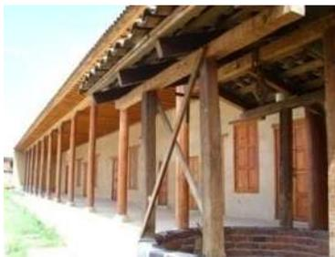
(Imagen 138) Intersección de columna, Arrastre, par o correas y tejas
