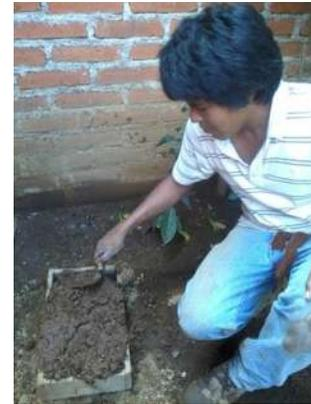
(Imagen 131) Llenado y compactado en el molde de lodo
