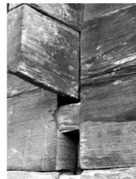
Las columnas son ancladas al arrastre por medio de un ensamble de espiga y escopladura de sección cuadrada y una pija que se le deja a la columna de las dimensiones que ensamble en el arrastre. En ocasiones estas columnas son desplantadas sobre bases de madera de sección cuadrada.
