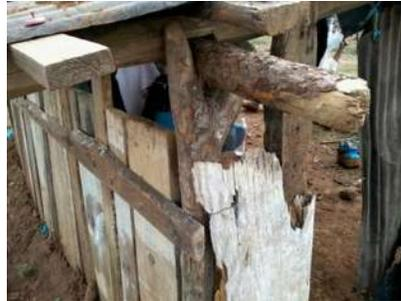
(Imagen 136) Intersección de columna, arrastre y un par
