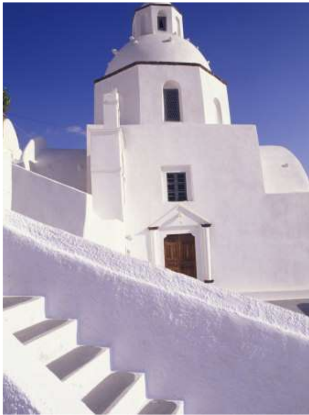
Imagen 13: edificio en blanco muestra como el color le da luz. Fuente www.art.com
