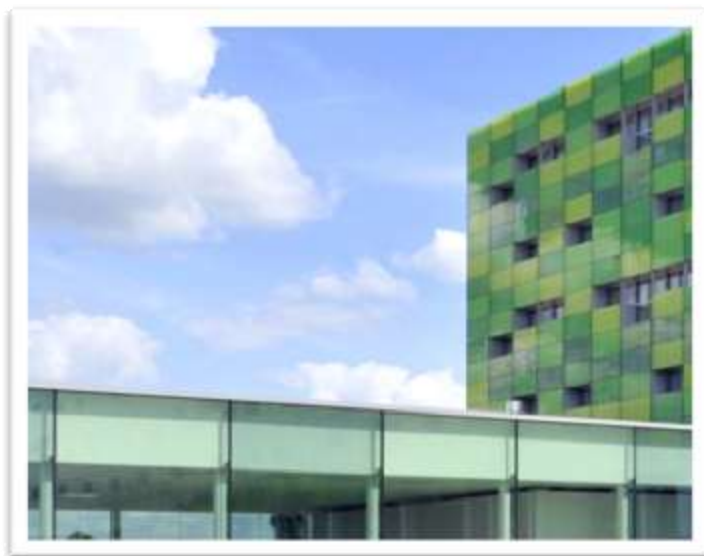
Fotografía 14 exterior de las Oficinas Infrac Occidente. Fotografía de Crepain Binst Architecture.
