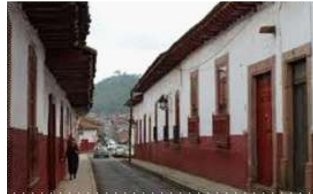
Fig. Imagen Exterior vialidad
