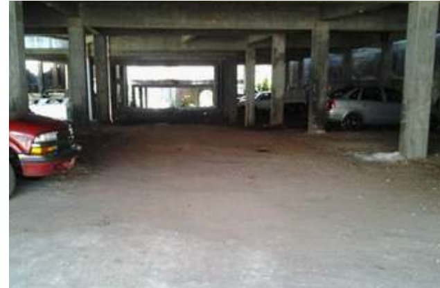
Imagen 9. Estacionamiento subterráneo de la nueva plaza del antojo en ciudad hidalgo
