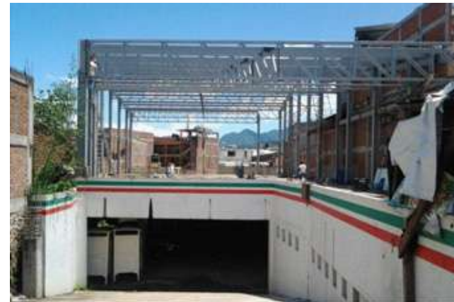
Imagen 10. Construcción de estructura de la plaza del antojo Ciudad Hidalgo Mich.
