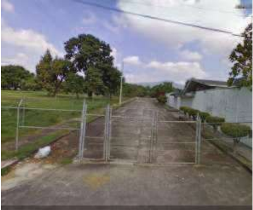
Imagen 30. Vista de la calle Álamos
