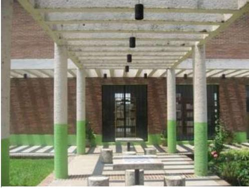
Fig. 53. Viguera de concreto en pasillos exteriores formando un pergolado. Foto: JAVM. 05/08/12
