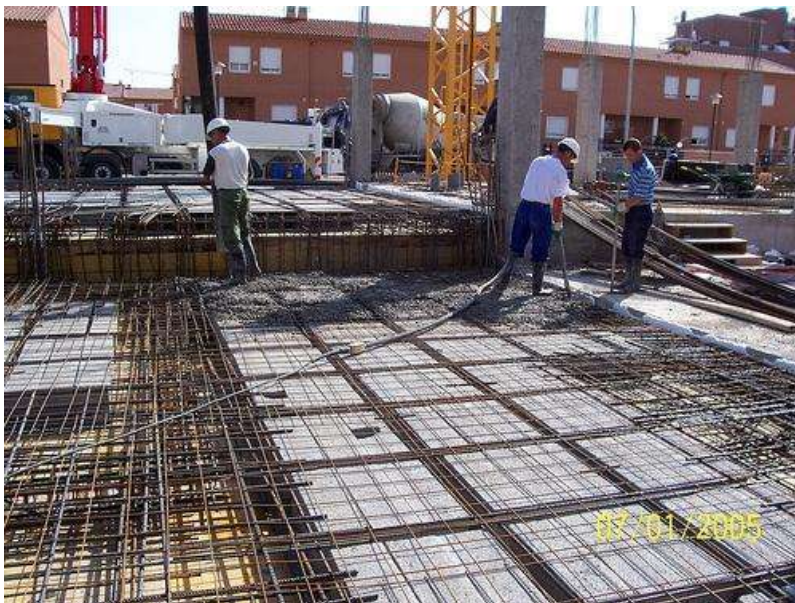
Ilustración 80/colocación de casetones/google imagenes
