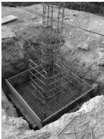
Ilustración 78/Zapata aislada de concreto, arena negra y acero/K.V.R
