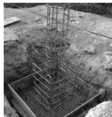
Ilustración 82 /Zapata aislada/google imágenes.
