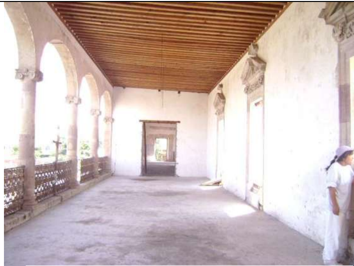
Foto12: Pórtico de la fachada de la hacienda. Planta alta
