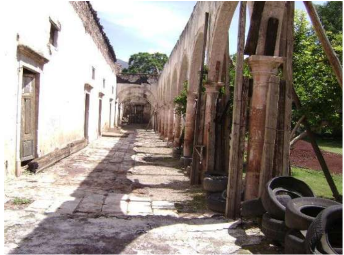
Foto32: Vista de los apuntalamientos en los arcos. Y techos
