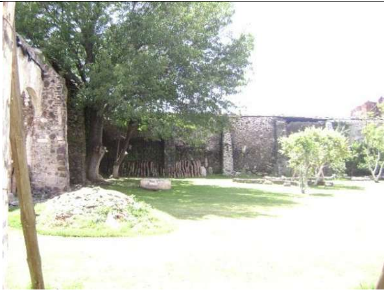
Foto17: Vista de muros de piedra.
