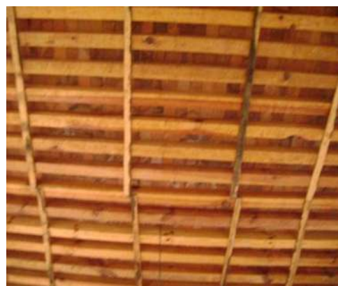
FOTO2: TECHO DE LA PARTE DE LA ENTRADA.
