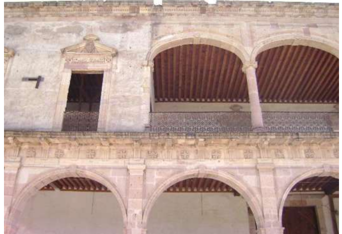
Foto30: Vista de fachada principal hecha de cantera.
