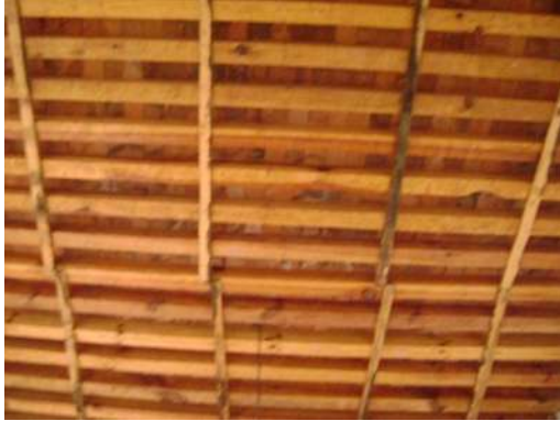
Foto21: techumbre de la parte principal del edificio.
