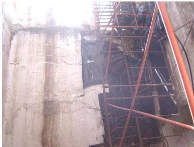
FOTO6: CUBO DE LA ESCALERA
