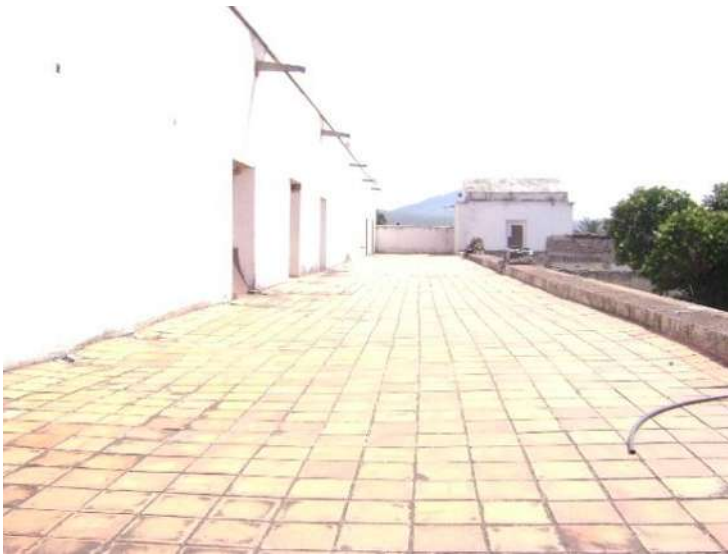
Foto13: Pórtico parte interior
