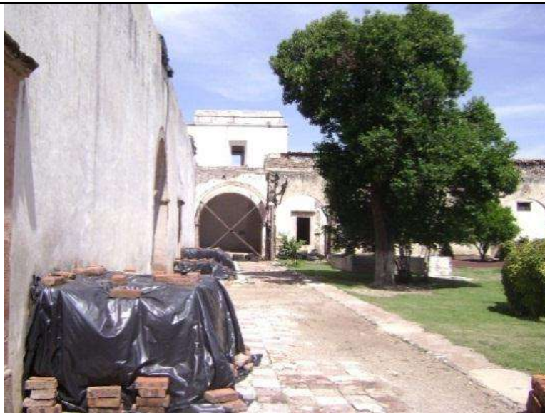
Foto: Vista hacia la capilla
