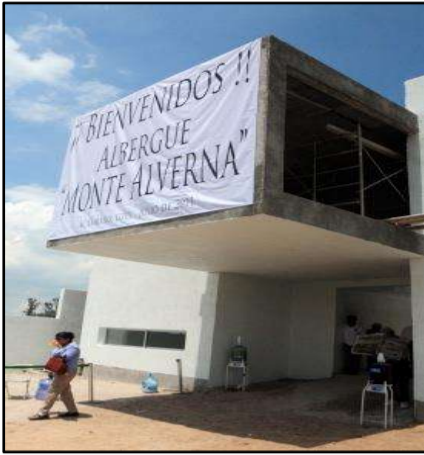
Ilustración 4. 5 Fachada en construcción del Albergue Alverna, Marina Rodríguez
