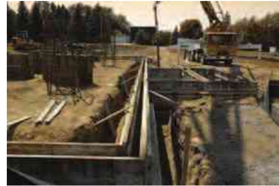
Fotografía de Armado de Zapatas FUENTE: construmatica.com
