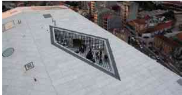
Imagen 7.36 Terraza ubicada en la cubierta del edificio.
