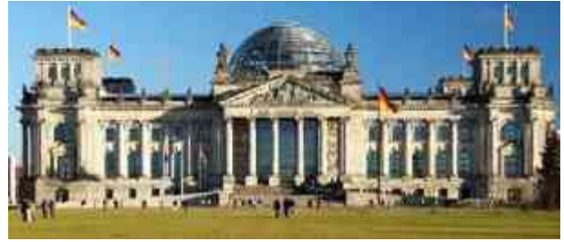
Imagen 7.25 Fachada principal del edificio.
