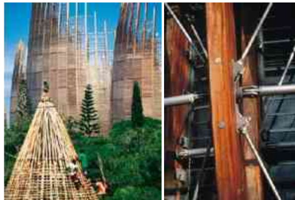
Imagen 7.60 Detalle de integración con las construcciones tradicionales, así como de la combinación de materiales modernos y tradicionales.
