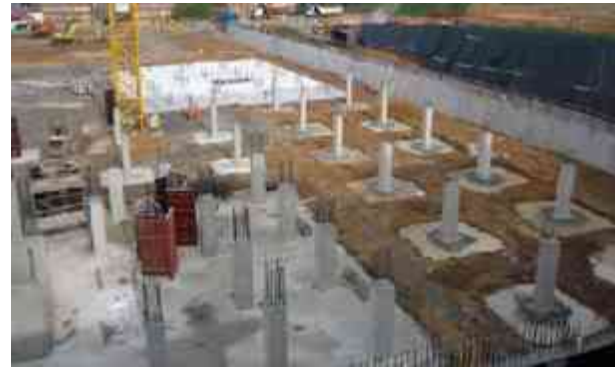
Imagen 1: Cimentación por medio de zapatas aisladas.
