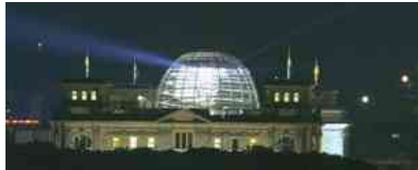
Imagen 7.31 Desempeño nocturno de la Cúpula del edificio.
