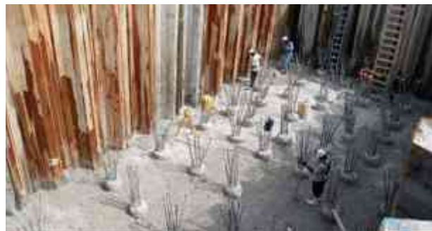
Imagen 1: Cimentación por medio de pilotes aislados.
