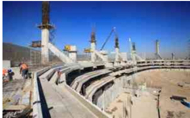
Mapa 1: Construcción de la estructura de concreto armado en columnas y trabes, mezclado con elementos prefabricados en las gradas. Estadio Omnilife Zapopan, Jalisco.
