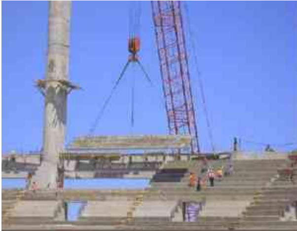
Mapa 1: Colocación de elementos prefabricados para formar la gradería del estadio Omilife, Zapopan, Jalisco.
