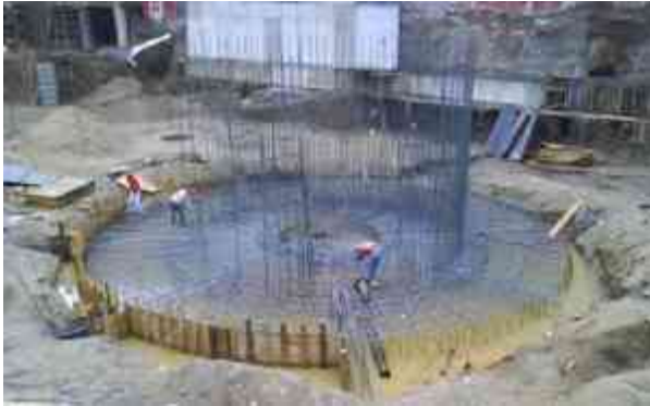
Mapa 1: Construcción de elementos para la cimentación del estadio Omnilife mediante concreto armado
