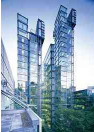
Imagen 7.8 Edificio para Lloyd's Register, Londres, Inglaterra; Richard Rogers, 1993-2000.
