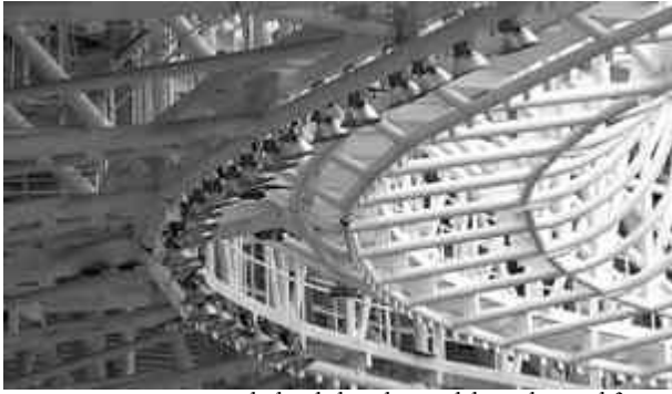
Mapa 1: Estructura tubular de la cubierta del estadio Omilife, Guadalajara, Jalisco.
