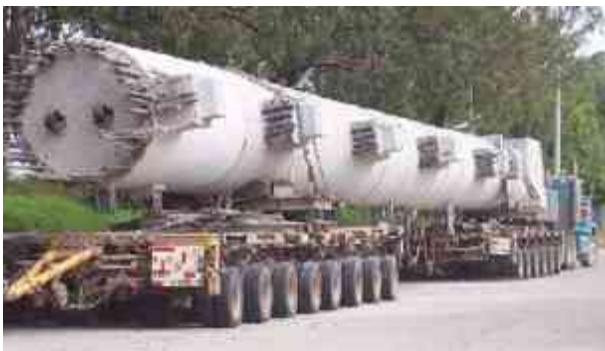
Mapa 1: Transporte de un elemento prefabricado que consta de una columna para el estadio Omnilife, Zapopan, Jalisco.
