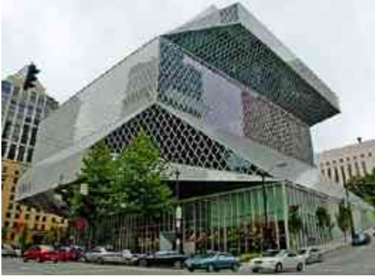
Imagen 7.38 Perspectiva exterior de la biblioteca.
