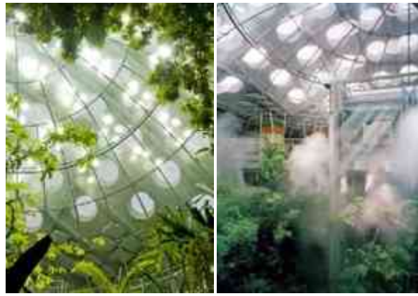
Imagen 7.69 Iluminación natural por medio de domos en los espacios interiores de exhibición de la selva.
