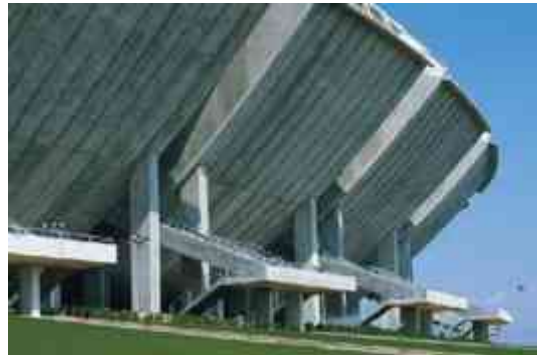
Imagen 7.56 Perspectiva exterior de la zona de escaleras que dan acceso a la parte superior del estadio.
