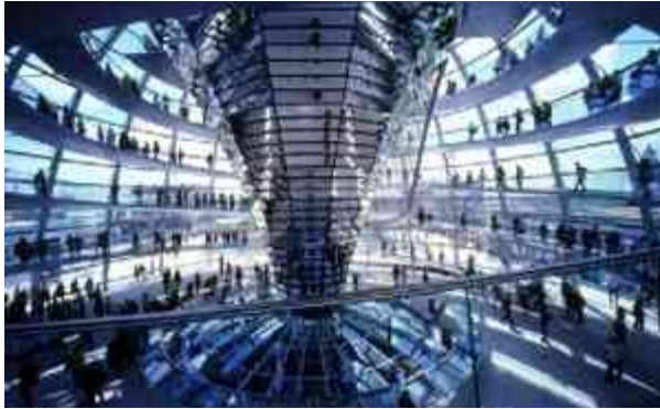
Imagen 7.28 Interior de la cúpula que muestra las rampas que a la vez funcionan como aleros de protección solar.
