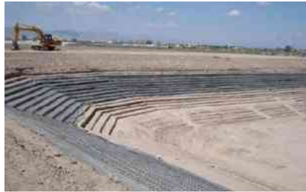
Mapa 1: Armado de acero para la estructura de concreto de las graderías del nuevo estadio corona de Torreón, Coahuila, las cuales están asentadas sobre terreno natural previamente formado por el sistema de terraplén.
