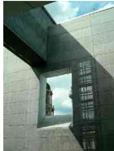
Imagen 7.50 Detalle del hueco en el muro limitante.
