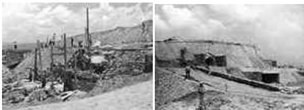
Imagen 7.89 Construcción de los terraplenes del estadio.
