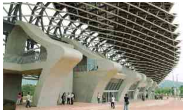
Imagen 1: Elementos estructurales de concreto armado del estadio Kaohsiung en Taiwán.
