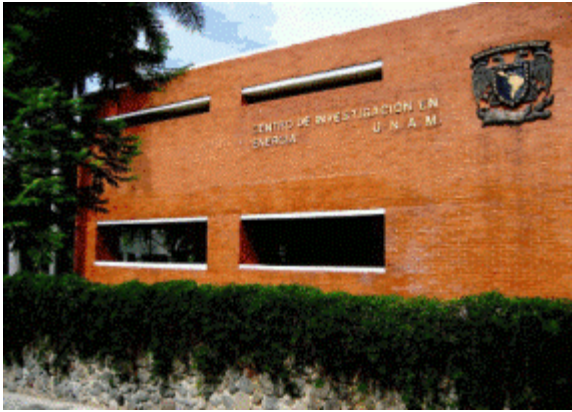
IMAGEN 2.11 – Acceso a CIE fachada auditorio. Fotografía propia.
