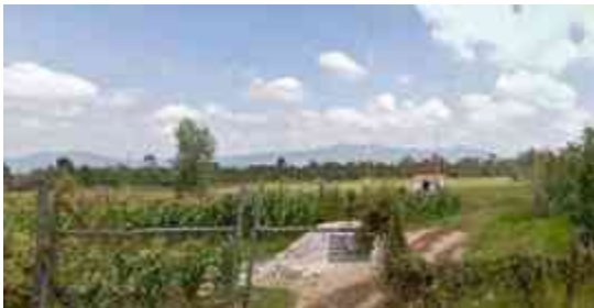
Imagen 3.30 – Frente de instalaciones UMSNH camino la arboleda antena de radio y estación. Fotografía propia.
