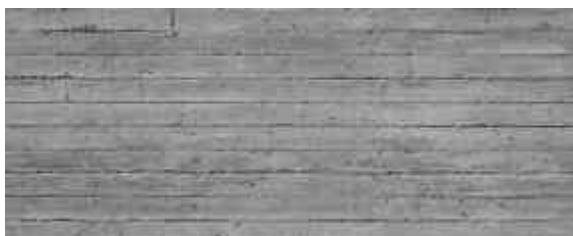
IMAGEN 9.13 – Textura de concreto colado con cimbra de madera. Fotografía propia.
