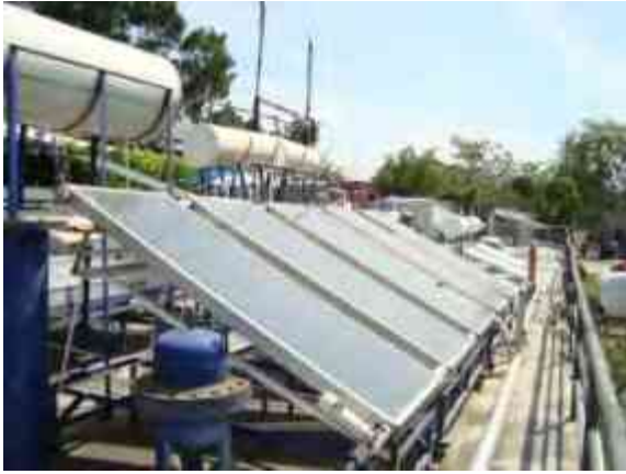
IMAGEN 2.19 – Plataforma solar 4. Fotografía propia.
