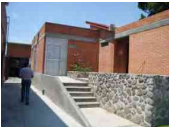
IMAGEN 2.31 – Exterior de talleres. Fotografía propia.
