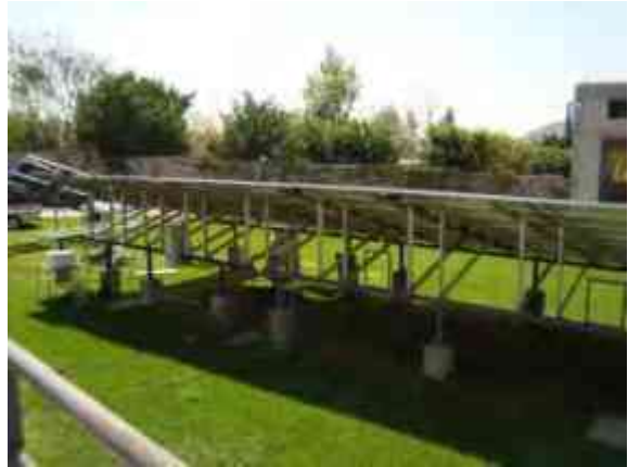
IMAGEN 2.22 – Plataforma solar 6. Fotografía propia.
