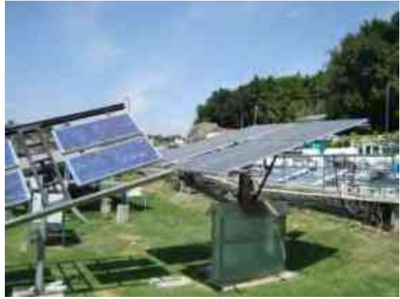
IMAGEN 2.20 – Plataforma solar 7. Fotografía propia.
