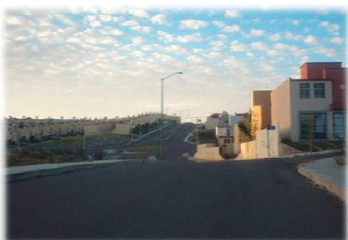
Imag. 20: Vista de la vialidad marcando uno de los accesos del terreno por el fraccionamiento, G.J. Cervantes Q.
