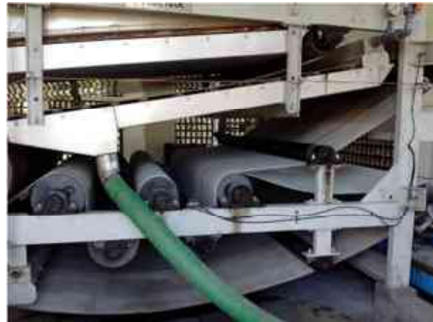
Figura 53. Filtro banda, trayectoria de los lodos para su deshidratación, fuente: captura autor.
