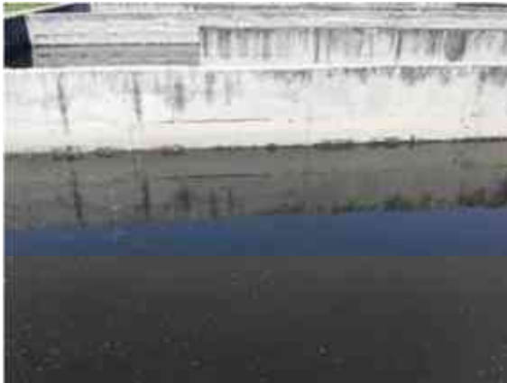
Figura 48. Tanque de contacto de cloro, se diseña en forma de laberinto, para mayor contacto con el cloro, en su recorrido hacia la salida, fuente: captura autor.
