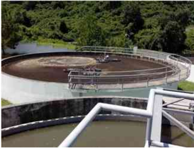
Figura 51. Tratamiento del lodo, mediante gravedad, fuente: captura autor.
