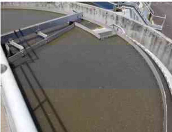
Figura 50. Tratamiento del lodo, mediante gravedad, fuente: captura autor.
