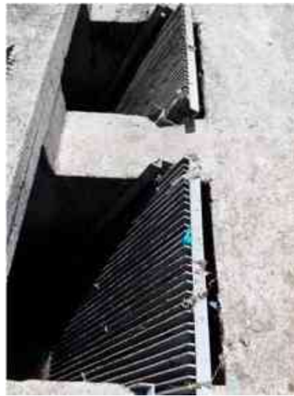
Figura 39. Rejillas de retención de basura, fuente: captura autor
