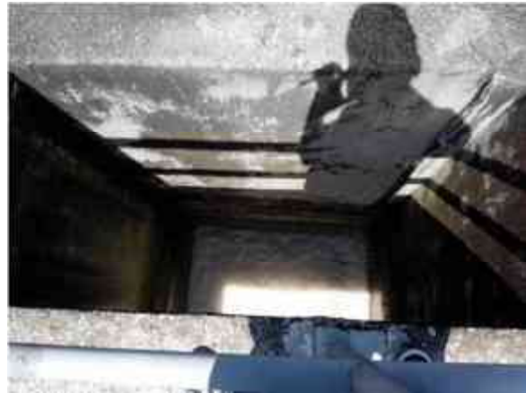
Figura 43.cajas de distribución, modulo "B", fuente: captura autor.
