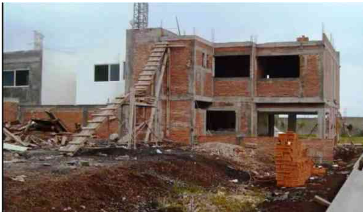
Figura 11. Vista proceso constructivo de las viviendas, fuente: captura autor.
