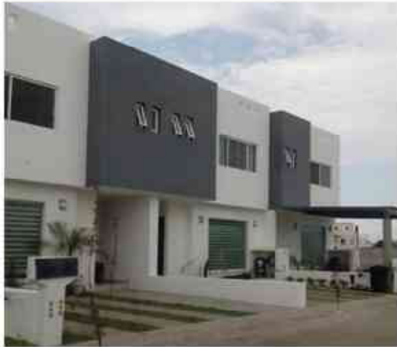
Figura 2. Fachada de casa tipo que presenta el fraccionamiento.
