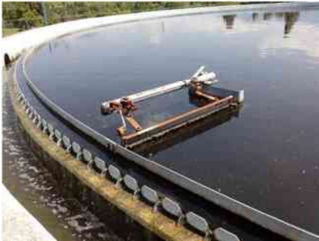
Figura 46. Sedimentador Secundario, con brazo desnatador, fuente: captura autor.
