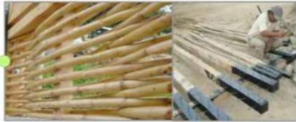
Columnas: La base de la columna que toma contacto con el concreto se baña previamente con pintura asfáltica para protegerla de la humedad y de la acción corrosiva del cemento.
