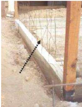
3.- Anclaje de paneles. Para anclar los paneles se podrán utilizar alambres fijados en el sobrecimiento.
