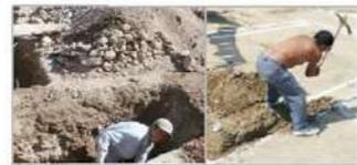
Excavación.- Para suelos rocosos, la zanja para los cimientos deberá tener 45 cm. de ancho, con una profundidad de 50 cm (hasta llegar a suelo firme).
