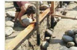
Detalle de anclaje de columnas de madera de pino de 4"x6"
