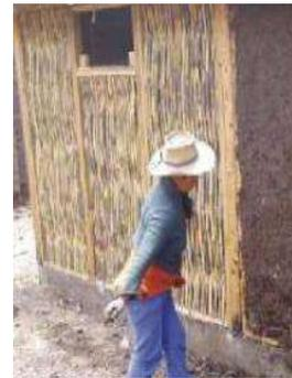
7.- Revestimiento de paneles. Recubrimiento primario de paneles utilizando el barro preparado, secar de 1 a 2 días.
