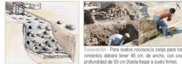
Excavación. - Para suelos rocosos, la zanja para los cimientos deberá tener 45 cm. de ancho, con una profundidad de 50 cm (hasta llegar a suelo firme).
