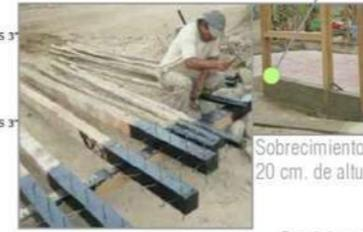
Columnas: La base de la columna que toma contacto con el concreto se baña previamente con pintura asfáltica para protegerla de la humedad y de la acción corrosiva del cemento.
