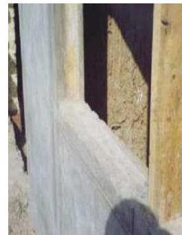
8.- Acabado final. Recubrimiento a base de cemento-arena sobre el embarrado previo.
