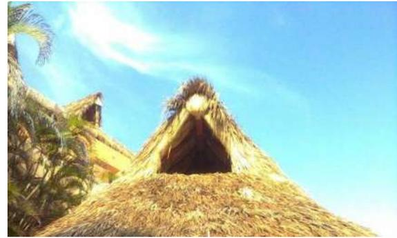
Figura N°\_ 104. Caballete. "Aberturas" en la cubierta superior para la circulación y salida de aire. WWW.FYM.MX.
