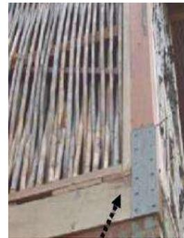
6.- Colocación de platinas. Uso de platinas como elementos conectores entre las vigas de madera de entrepiso
