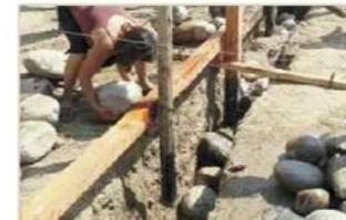
Detalle de anclaje de columnas de madera de pino de 4"x6"
