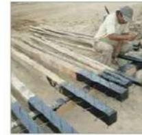
Columnas: La base de la columna que toma contacto con el concreto se baña previamente con pintura asfáltica para protegerla de la humedad y de la acción corrosiva del cemento.
