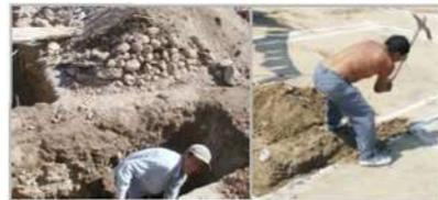
Excavación - Para suelos rocosos, la zanja para los cimientos deberá tener 45 cm. de ancho, con una profundidad de 50 cm (hasta llegar a suelo firme).
