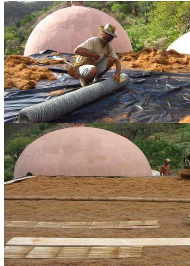
Figura N°\_ 110. Instalación de malla electrosoldada y fibra de coco. NMG.
