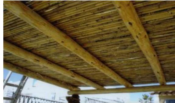
Figura N°\_ 107. Detalle de la disposición de los carrizos sobre las vigas. PVM.
