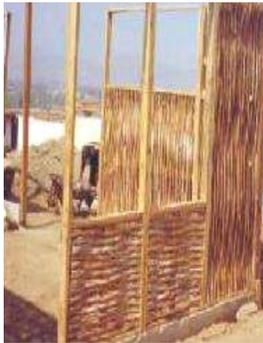
4.- Montaje de Paneles. Se colocara la viga collar en el borde de los paneles de bahareque.
