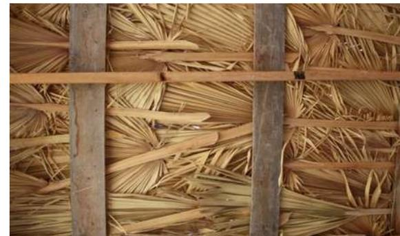
Figura N°\_ 105. Detalle de instalación de palma real. PVM.
