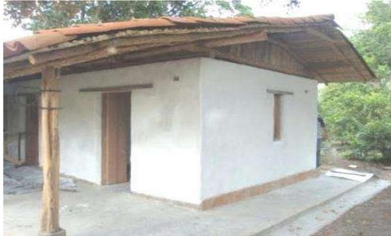
Figura N°\_ 97. Vivienda terminada, hecha con muros de bahareque prefabricado. NMG.
