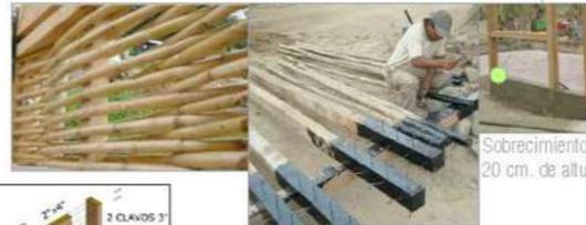
Columnas: La base de la columna que toma contacto con el concreto se baña previamente con pintura asfáltica para protegerla de la humedad y de la acción corrosiva del cemento.
