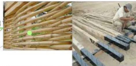
Columnas: La base de la columna que toma contacto con el concreto se baña previamente con pintura asfáltica para protegerla de la humedad y de la acción corrosiva del cemento.
