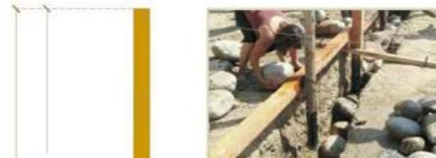
Detalle de anclaje de columnas de madera de pino de 4"x6"
