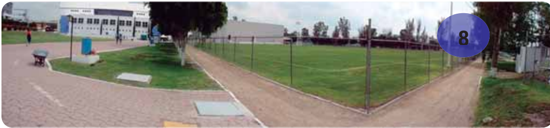
Ilustración 62. Vista Panorámica 7, Acceso a l terreno, foto tomada por E.B.J.
