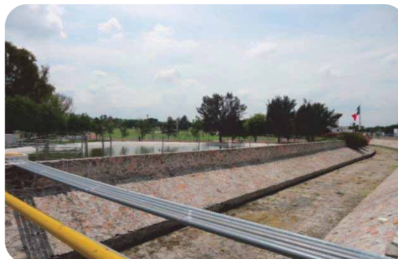
Ilustración 52. Canal de Aguas Pluviales dentro del terreno propuesto, foto tomada por E.B.J.
