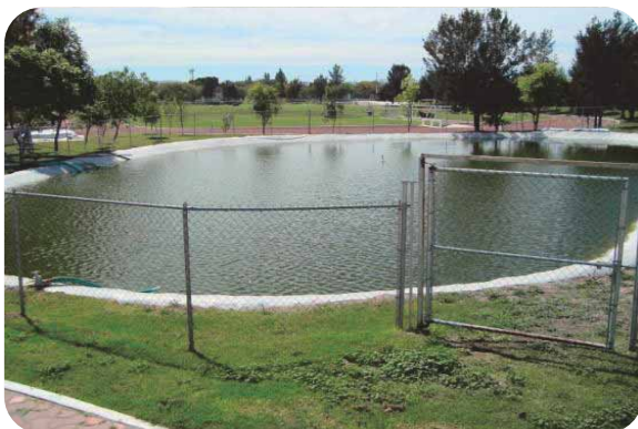
Ilustración 51 Lago de Agua Tratada para Riego de Áreas Verdes en el terreno propuesto, foto tomada por E.B.J.
