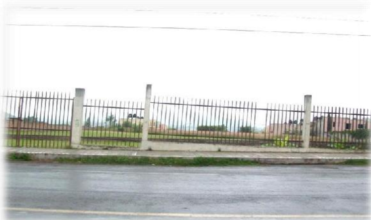
IMG No.44 Terreno Uno Frente GTG-9/9/2011
