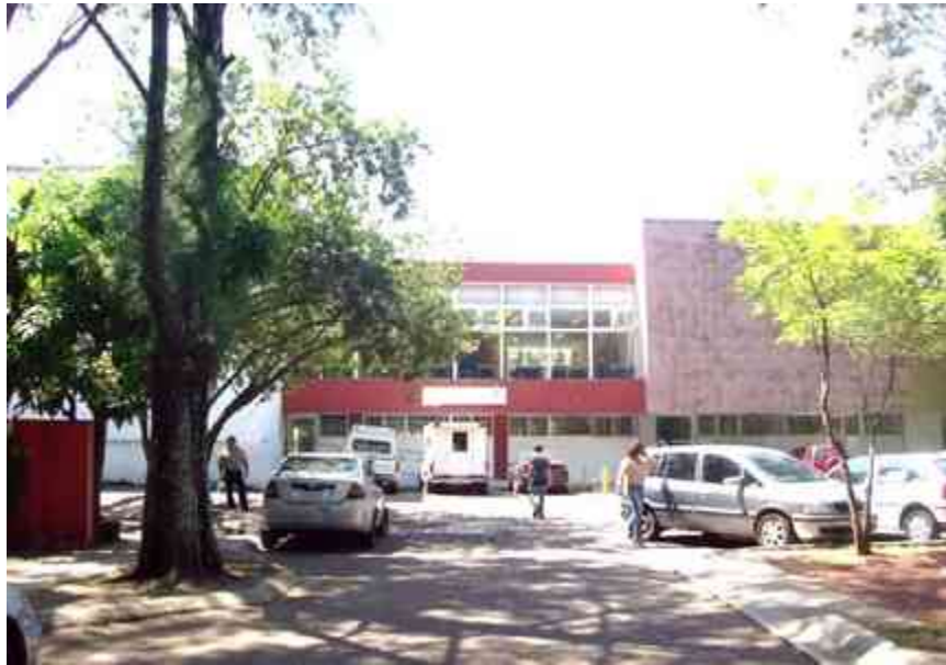
IMG No.19 Fachada de la calle Ticateme GTG 23-sep-11
