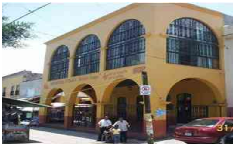
IMG No.29 Foto de la fachada principal GTG 24-agosto-2011
