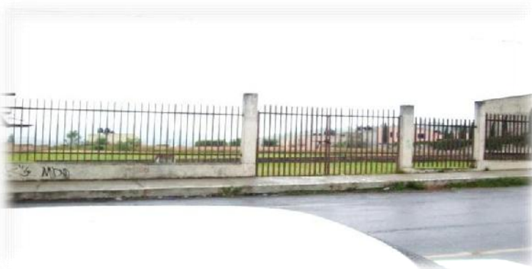
IMG No.45 Terreno Uno Frente dos GTG 9/9/2011
