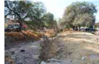
Situación presentada en la zona de intervención del arroyo Ejido
