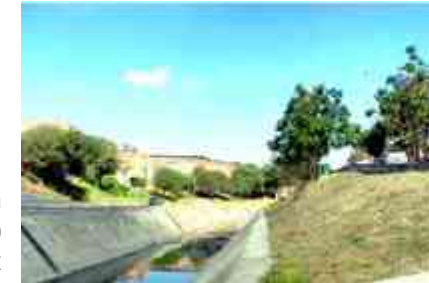
Situación presentada en la zona de intervención del río Los Gómez
