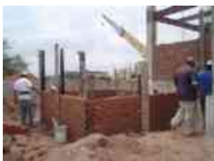
Imagen 109) Muro de tabique de barro rojo recocido.
