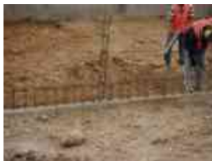
Imagen 113) Armado de cadena de desplante.
