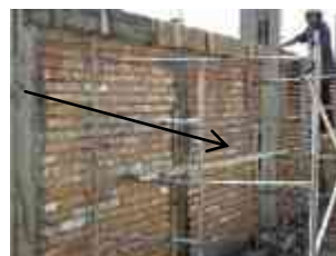
Imagen 110) Muro de tabique de barro rojo recocido.
