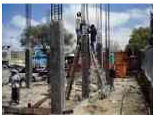
Imagen 107) Columna de concreto.
