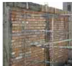
Imagen 116) Descimbrado de cadena de cerramiento de concreto armado.
