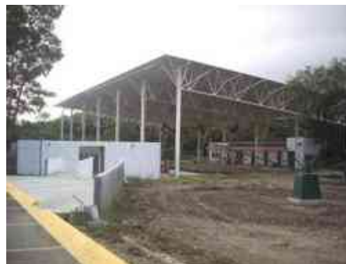
Imagen 81) Vista general de las nuevas instalaciones.
