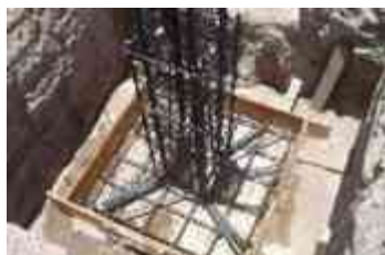
Imagen 104) Zapata aislada con cimbra. Fuente: < http://www.arghys.com/construcciones/fotos/construcciones/Procesos-constructivos-de-una-zapata-aislada-300x224.jpg > consultada el martes, 23 de julio de 2013.
