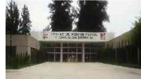
Ilustración 114 Acceso Fachada Principal Fuente: M. Julieta Gutiérrez Arreaga
