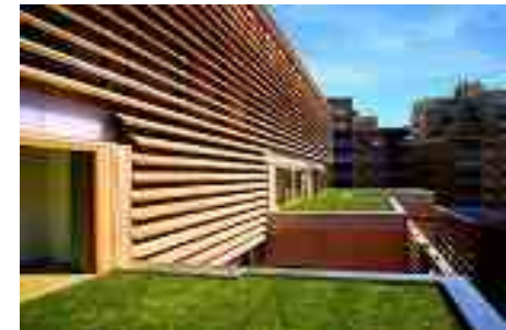
Ilustración 88 Fachada de tabloncillos de madera
