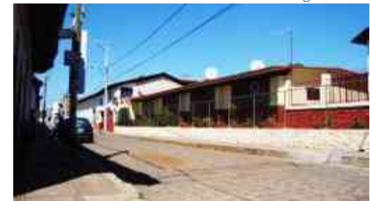
Ilustración 48 Escuela Primaria del centro de Villa Morelos Mich. Autor: M. Julieta Gutiérrez Arreaga
