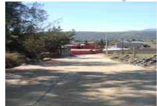
Ilustración 41 Pavimentación de Calle de Acceso al Terreno Autor: M. Julieta Gutiérrez Arreaga
