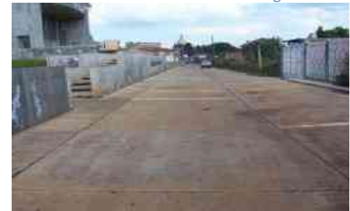
Ilustración 40 Pavimentación de Calle Autor: M. Julieta Gutiérrez Arreaga
