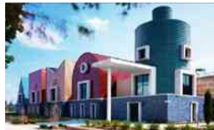
Ilustración 93 Fachada del conjunto
