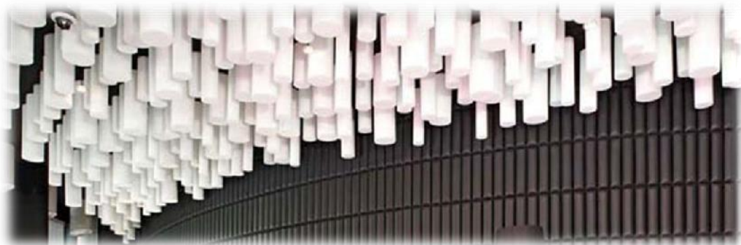
IMAGEN 189. Materiales absorbentes suspendidos en el techo de un lobby de un hotel; en el que se observa que los elementos fueron colocados en el plafón generando una composición agradable al espacio, respondiendo a las necesidades que requerían de acústica. Imagen obtenida en: http://www.culturadeco.com
