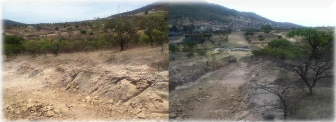
IMAGEN 93. Pendiente que presenta el predio propuesto, en la imagen izquierda se observa el desnivel entre la avenida principal y el terreno. En la derecha se analiza la excavación de la línea de drenaje del fraccionamiento. Fotografía tomada por: Martín Rubio Avalos. Imagen editada por: Ismael Vázquez Betanzos,
