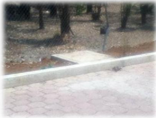
IMAGEN 152. Registros de la Instalación Eléctrica del campus de la ENES Unidad Morelia, se observa el registro en la periferia al circuito vehicular y colindante al terreno para la propuesta arquitectónica. Fotografía: Ismael Vázquez Betanzos.
