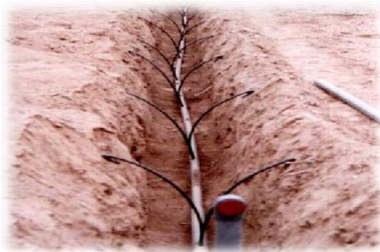
IMAGEN 118. Conexión de las tuberías terciarias de los laterales de riego; se observa la excavación de la zanja. Imagen obtenida en "LOS SISTEMAS DE RIEGO POR GOTEO Y MICRO ASPERSIÓN".
