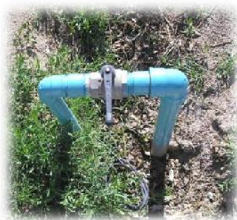
IMAGEN 121. Dispositivo final en la tubería terciaria o "Purgador", que sirve para purgar y limpiar la tubería de materia orgánica o restos de materiales sólidos, como tierras arenas, sedimentos que en ocasiones llegan a taponear el sistema obstruyendo el paso del agua y deteriorando el sistema. Imagen obtenida en "LOS SISTEMAS DE RIEGO POR GOTEO Y MICROASPERSIÓN".
