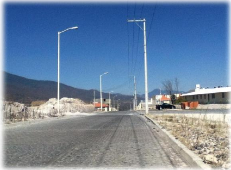
IMAGEN 88. Avenida principal de acceso al fraccionamiento mencionado, avenida colindante al predio propuesto para la propuesta arquitectónica. Se aprecia el servicio eléctrico del fraccionamiento por medio de los postes y las líneas de conducción; mientras que por la otra banqueta las luminarias del desarrollo habitacional. La calle principal y las banquetas están pavimentadas, mientras que las calles secundarias colindantes aún están por pavimentar. Fotografía: Ismael Vázquez Betanzos.
