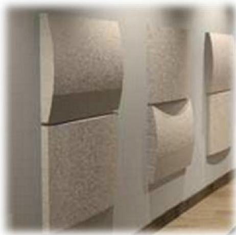
IMAGEN 223. Se muestra un ejemplo de difusor cilíndrico colocado en uno de los muros de un espacio arquitectónico. Imagen obtenida en: http://www.acusticasansegundos.com
