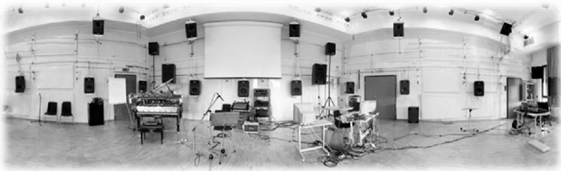
IMAGEN 20. Se muestra el interior del IMA en Alemania, se observa a manera de panorama 3 de las 4 paredes que encierran el espacio. Se muestra la disposición de las bocinas tanto en el plafón como en los muros y sobre el piso; se observa también una pantalla de proyección para obras audiovisuales. Imagen obtenida en: http://www.iem.kug.ac.at/en/intitute-of-electronic-music-and-acoustic.html
