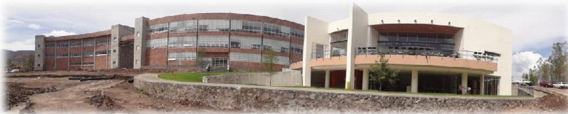
IMAGEN 155. Fotografía panorámica de la imagen urbana de la ENES Unidad Morelia colindante al terreno para la propuesta arquitectónica; en el fondo se observa el edificio de docencia, mientras que de lado derecho se aprecia el edificio de cafetería del campus; en primer plano se observa una fracción del terreno. Fotografía tomada por: Ismael Vázquez Betanzos.
