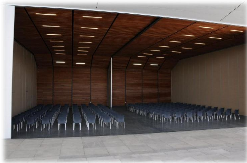
IMAGEN 206. Resonadores dentro de un espacio que necesita ciertas características acústicas para un buen funcionamiento de la sala del CIAC del Arq. Teodoro González de León dentro de la UMSNH. Los listones de madera están seccionados por razones constructivas y parten del suelo recorriendo todo el muro y extendiéndose hasta el plafón, generando una composición agradable; es importante mencionar también los paneles de tela que resultan extraordinarios para absorber el sonido en los costados del espacio. Aquí se muestran dos ejemplos de materiales absorbentes: los resonadores y los aislantes acústicos de los costados. Imagen obtenida en: http://www.skyscrapercity.com
