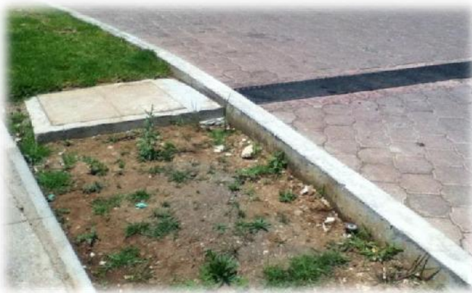
IMAGEN 147. Rejilla colocada en el circuito que rodea el campus, como “boca de tormenta” que capta el agua de lluvia. Fotografía: Martín Rubio Avalos.
