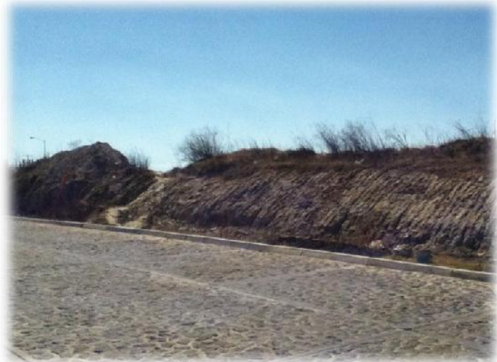
IMAGEN 89. Colindancia del predio con la avenida principal, se aprecia el desnivel de la banqueta respecto al terreno propuesto. Cabe mencionar que el área de donación municipal se encuentra a la entrada del “Fraccionamiento Arko San Pedro”. Fotografía: Martín Rubio Avalos.
