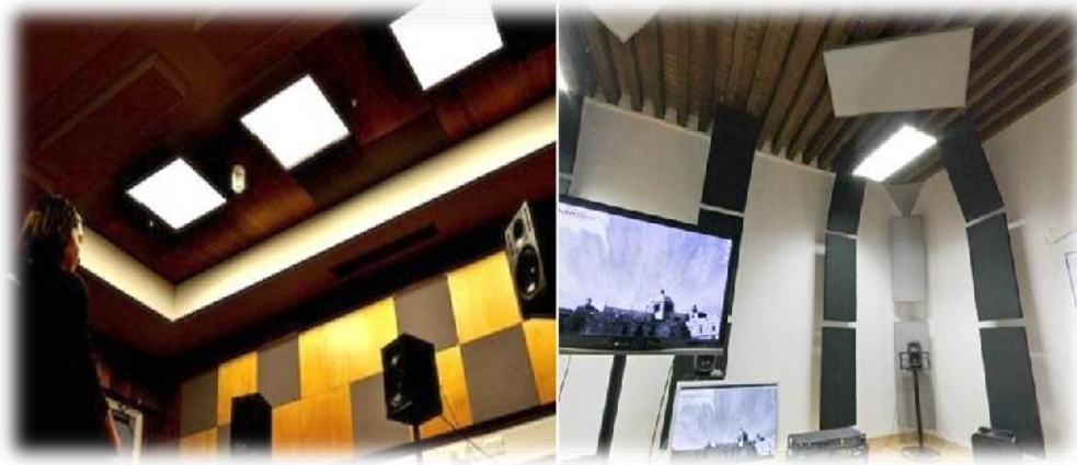
IMAGEN 8. En la izquierda se muestra uno de los estudios de grabación del SARC. En la derecha se muestra uno de los estudios de grabación del CMMAS. Se aprecia claramente las condiciones de adaptarse al espacio construido, para lograr la acústica y evitar reverberaciones se colocaron mamparas de madera con recubrimiento en tela para absorber las ondas de sonido tanto en los muros como en el plafón. Imagen obtenida en: http://www.hallblackdouglas.co.uk http://www.cmmas.org
