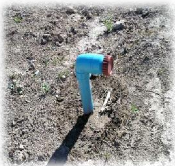
IMAGEN 121. Dispositivo final en la tubería terciaria o "Purgador", que sirve para purgar y limpiar la tubería de materia orgánica o restos de materiales sólidos, como tierras arenas, sedimentos que en ocasiones llegan a taponear el sistema obstruyendo el paso del agua y deteriorando el sistema. Imagen obtenida en "LOS SISTEMAS DE RIEGO POR GOTEO Y MICROASPERSIÓN".
