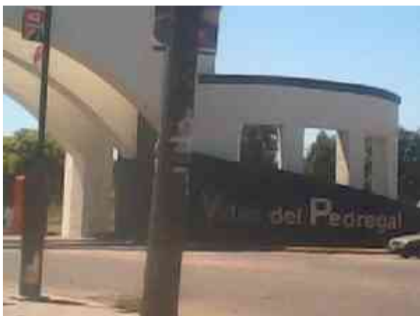
Figura107.- Imagen fotográfica del Acceso al Conjunto Habitacional, tomada por Luis Enrique barrera V.
