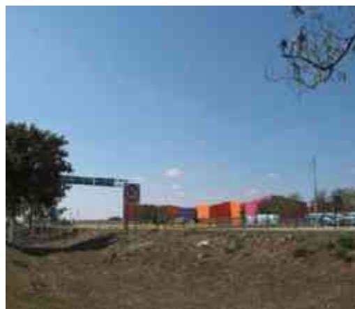
Figura 61.-Fachada del CRIT TELETON.Paralímpico.=1 4: 50.18/12/12.
