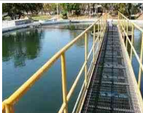
Imagen 4.11 Planta de Tratamiento de Aguas Residuales www.vozdemichoacan.com.mx
