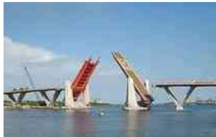
Imagen 2.26 Instalaciones Portuarias API Fuente: Elaboración propia
