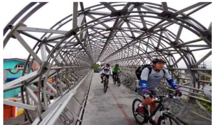
Ilustración 15: Puente del cicloférico . LEON GTO.
