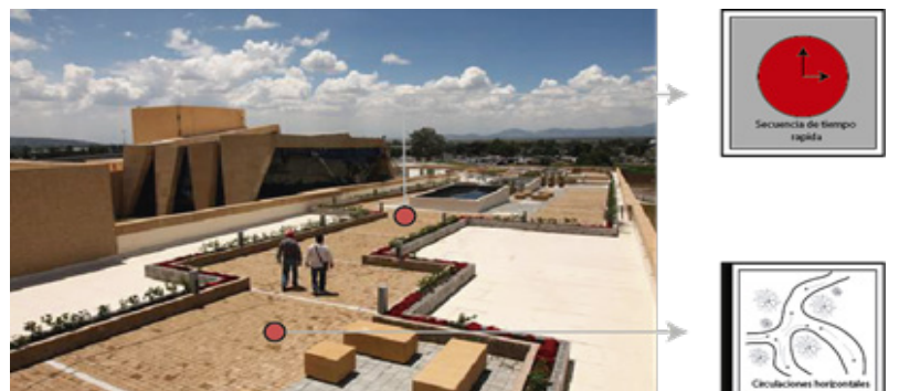
Ilustración 29.- Circulaciones horizontales, fotografía obtenida de [ http://ccmbicentenario.wordpress.com/about/ ]
