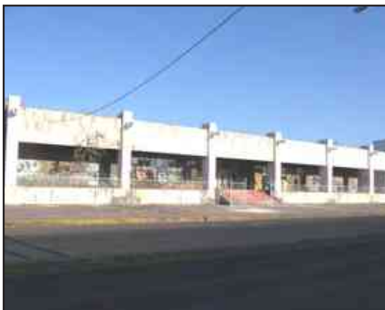
Imagen 2. Antigua estación del ferrocarril
