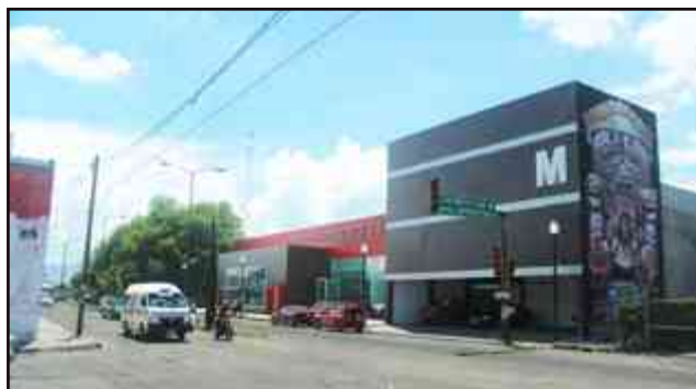
Imagen 67. Alumbrado público FOTO: TMMG Octubre 2012
