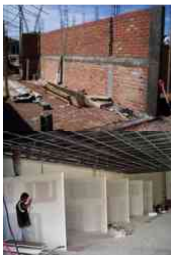
Fig. 39. Instalación de muros de tabla roca y elaboración de muros de tabique los cuales se usaran en el proyecto. Foto A.S.V. 2013
