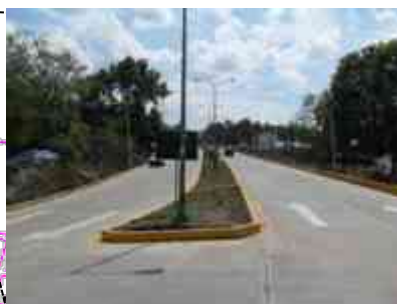
Fig.20. Acceso norte por la carretera municipal Coeneo-Huaniqueo, proveniente de los municipios Huaniqueo y Morelia, y la autopista de occidente México – Guadalajara. Foto A.S.V. 2013
