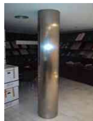
Fig. 38. Columna de acero con recubrimiento de láminas de acero inoxidable. Foto A.S.V. 2013.
